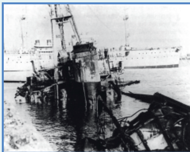
Partie centrale et avant, de l'épave du Pluton, fin 1939.
